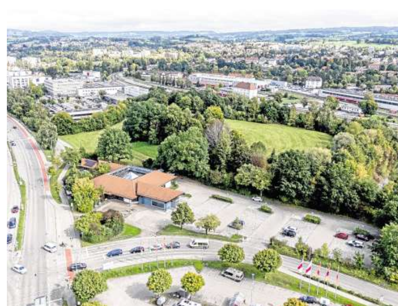
Auf dem Gelände der Zulassungsstelle in Kempten an der Bahnhofstraße will der ZAK ein neues Wertstoffzentrum errichten. Foto: Ralf Lienert
